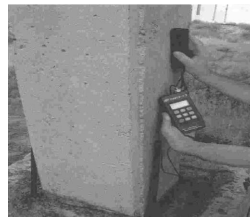
Рис.2 Определение защитного слоя бетона прибором Поиск-2.5
